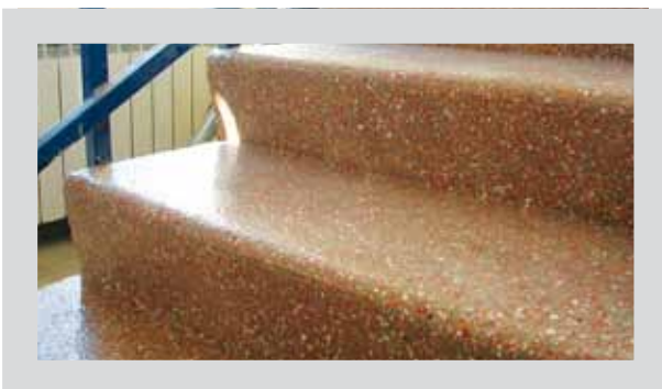
ОАО «Сарда» - полимерное покрытие с чипсами на лестнице
