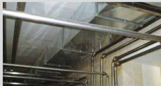
Бутурлинский молочный завод - монтаж приточно-вытяжной вентиляции
