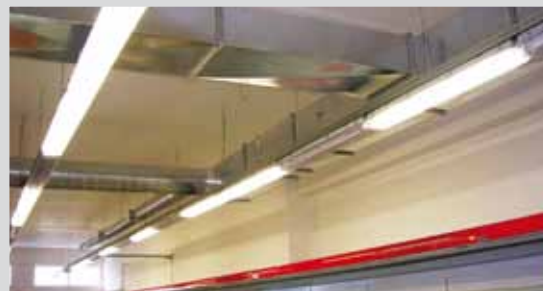
ТЦ «Самохвал» - устройство приточно-вытяжной вентиляции
