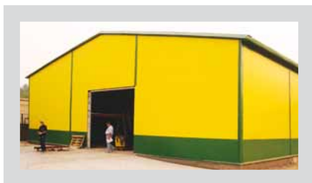
ООО «Кассиопея» - строительство склада
