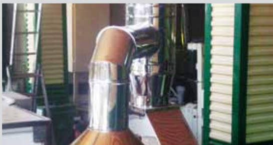
ООО «Починковский хлеб» - устройство систем вентиляции
